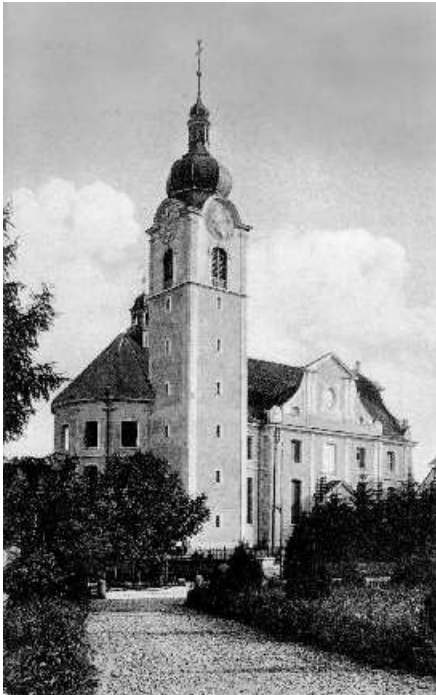
Aufnahme kurz nach der Renovation 1909/10 mit den hellen Lisenen und dem dunklen Verputz. Foto: S. Straub, Archiv Kantonale Denkmalpflege.
