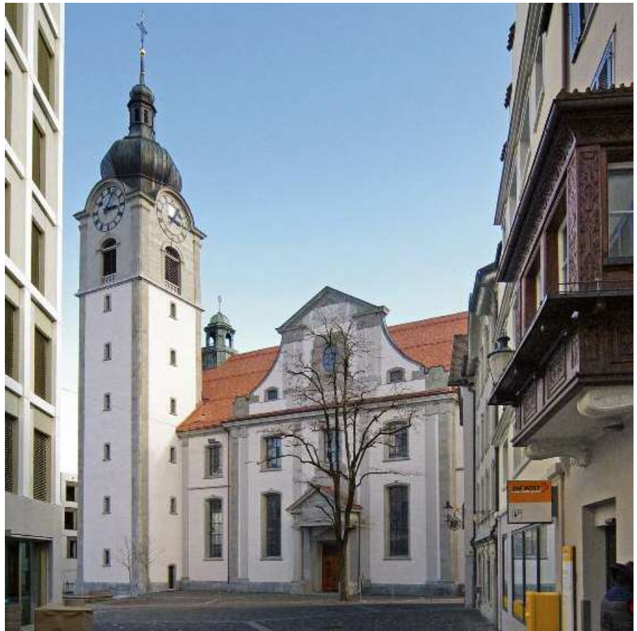
Nordfassade nach der Renovation 2018, die grau gestrichenen Lisenen heben sich jetzt wieder von der Fassade ab.
