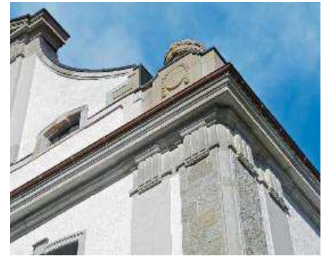
Das Grau der Putzlisene versucht sich dem Sandstein anzugleichen.
